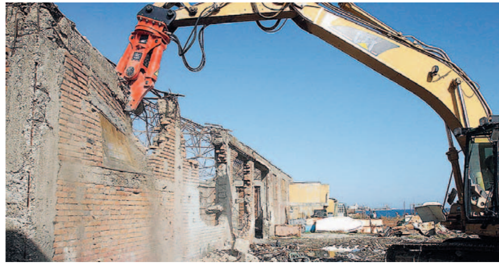
La demolizione con il nuovo mezzo a tenaglia. In alto e sotto le aree ancora "occupate" da Veterinaria
