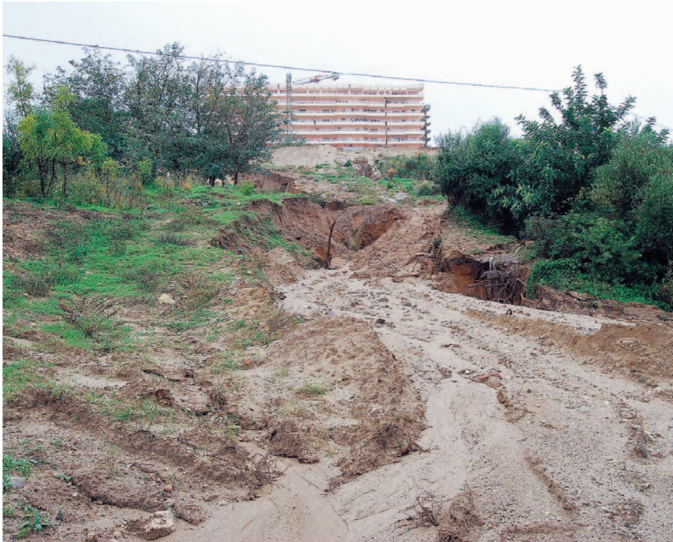
Sempre più preoccupante lo stato di dissesto idrogeologico nella zona del torrente Trapani sottoposta a eccessivo carico urbanistico
